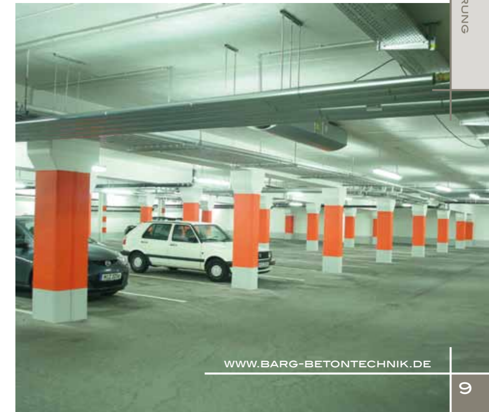
Sanierung eines Parkhauses
